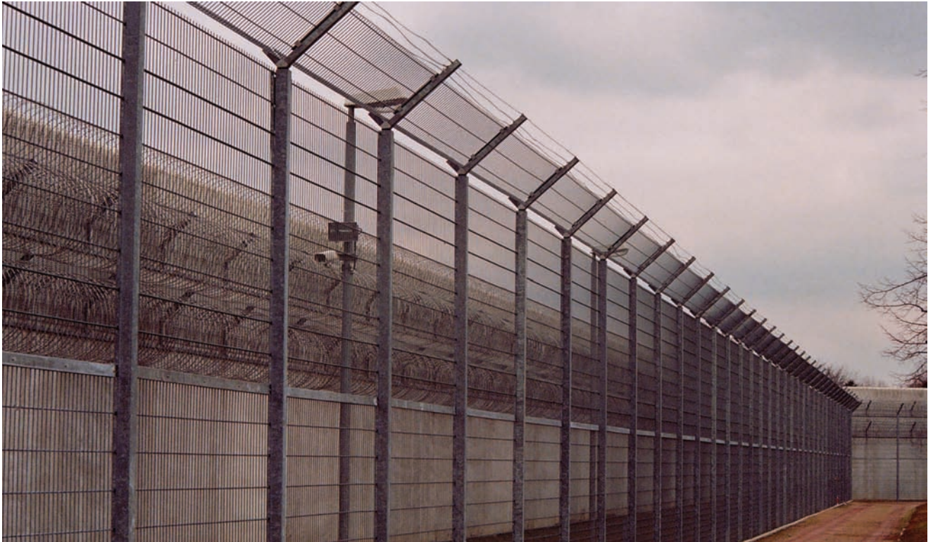
Abschiebungshaftanstalt Ingelheim © DWHN / R. Frey
